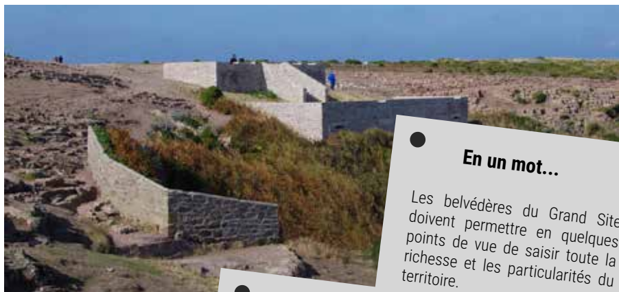
Aménagement du belvédère sur l'emprise de l'ancien restaurant de la Fauconnière, cap Fréhel.
